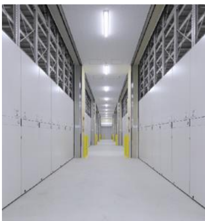
<管理体制の整備された 2nd STORAGE 倉庫>
