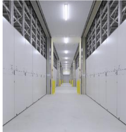
<管理体制の整備された 2nd STORAGE 倉庫>
